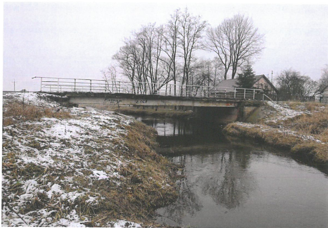
Rys. 2 Widok obiektu od wody górnej
